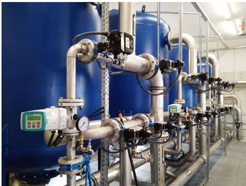
Fot 1. Stacja Uzdatniania Wody w Serocku
