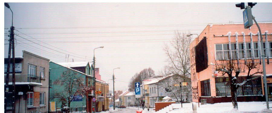
Widok od strony ul. Pułtuskiej
